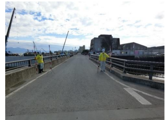
逆瀬川橋現況
